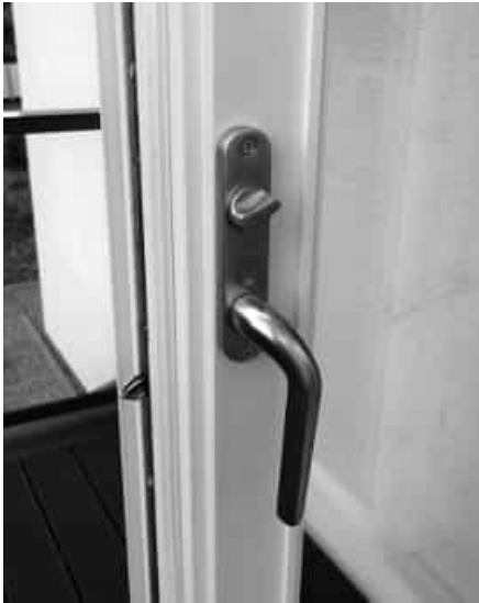
Alumiinipintaisen parvekeoven vääntönuppi ja pitkäsulkija, painike kiinniasennossa
